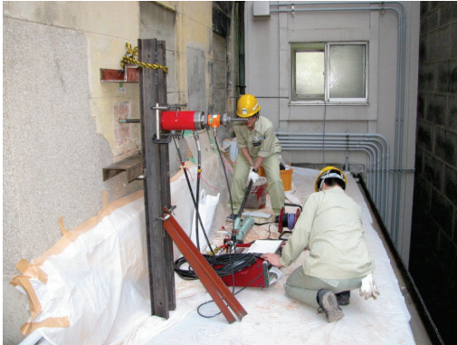
あと施工アンカーの引抜き試験
