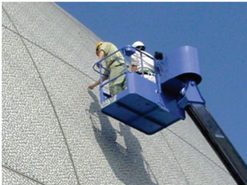
高所作業車による外壁調査
