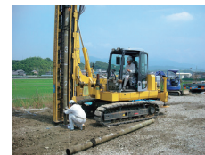
写真-2 施工状況
