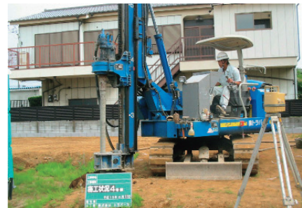
写真-1 施工状況
