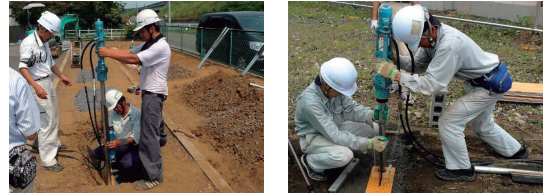
①杭の建込み→②杭の貫入→③貫入完了
