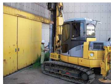
写真-3 構造物に接近した施工
