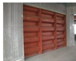
波鋼板耐震壁の設置状況
