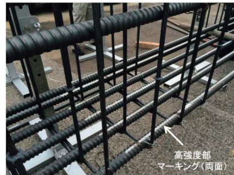
写真-1 ダブルスタークの配筋例
