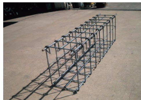
写真-2 現場組立 鉄筋スポット先組工法ユニット
