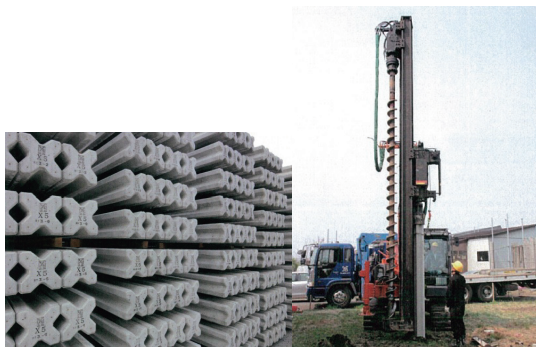
写真-1 補強材および施工状況
