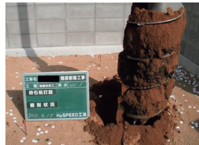
写真-1 土質確認状況
