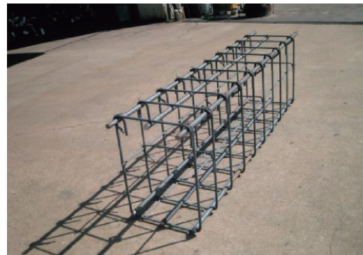
写真-2 現場組立ユニット
