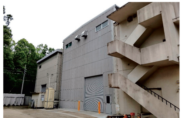
写真-2 大型構造実験棟増築部外観（中央部分）
