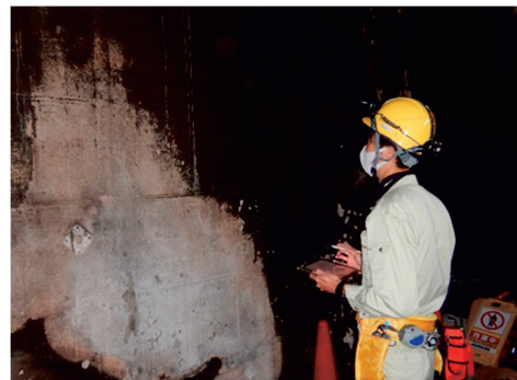
(b) 火害調査における外観目視調査
