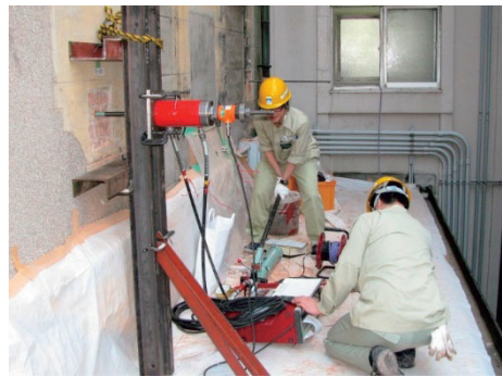
(a) 構造調査におけるあと施工アンカーの引張試験
