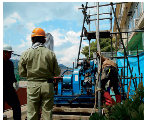
写真-12 既存建築物支持地盤のボーリング調査
