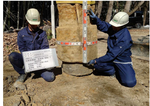
写真-1 築造した拡径部の一例
