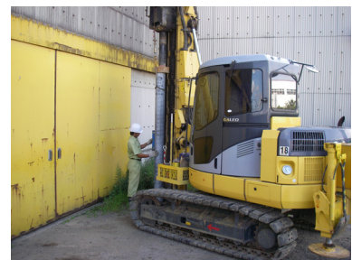
写真-3 構造物に接近した施工
