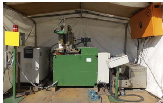
写真2 機材設置状況
